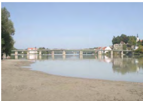
Brücke Schärding - Neuhaus
