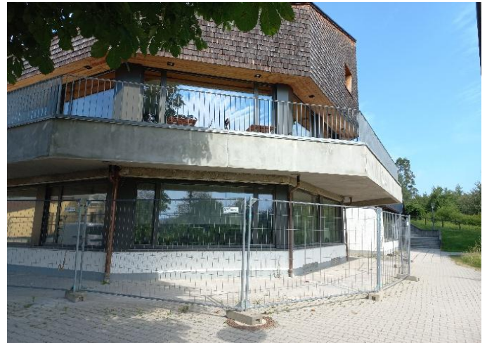
Balkonsanierung Haus des Gastes – Foto: Gemeinde Neuhaus a.Inn
