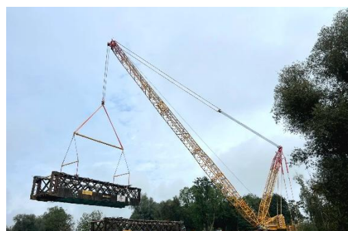
Die Holzbrücke wurde mit einem Kran herausgehoben und mit einem Tieflader in die Feldwerkstatt abtransportiert. Foto: Gemeinde Neuhaus a.Inn
