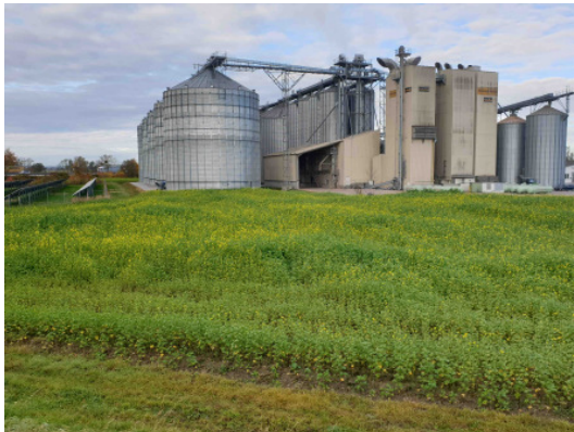
Blick von St 2110 nach Westen; Fläche Geltungsbereich
